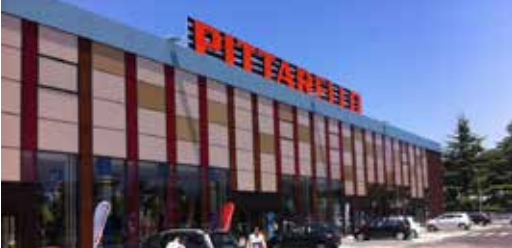
Pittarello, Roma - 2.000 m 2 di CGL 20cy Protezione dal fuoco
