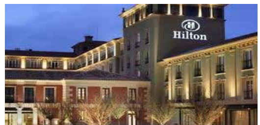
Hilton Hotel Como - Autorimessa con CGL 20cy Protezione dal fuoco
